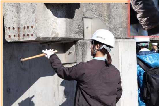
◆教材モデルによる実体験 (打音検査・施工不良の確認)
