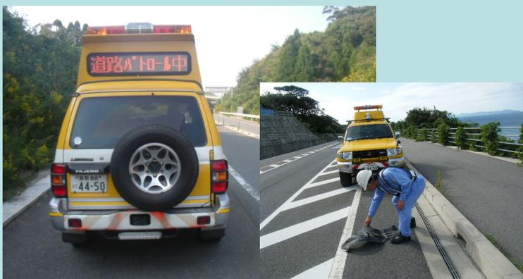
管内の国道9号のパトロールを行い、車や人が通行するのに危険がないか点検をするとともに、応急措置などを行います。1日約300kmの距離をパトロールしています。
