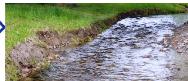
洗掘箇所補修を実施
