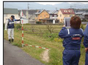
堤防点検の様子
