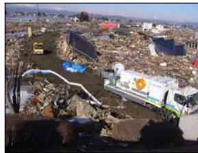
宮城県名取市 排水ポンプ車 (30m 3 /分) による排水状況
