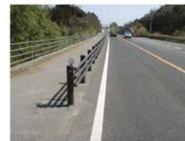
2 安全施設を設置します
