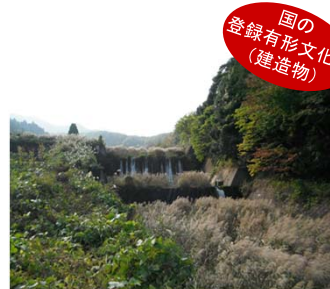
清水谷川第1号堰堤（倉吉市関金町堀） （張石コンクリート式/S12.7）
