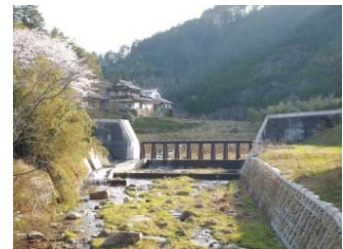
矢握砂防堰堤（倉吉市関金町山口） （鋼製スリット式/H14.1）
