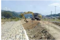
洪水があふれないようにする堤防整備 (三朝町若宮)
