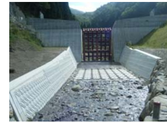
大谷砂防堰堤（東伯郡三朝町大谷） （鋼製スリット式/H27.10）
