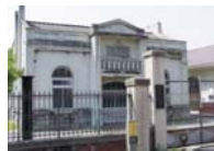
レトロモダンなポンプ室
