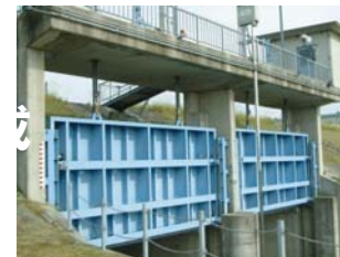
排水樋門 (北田川)
