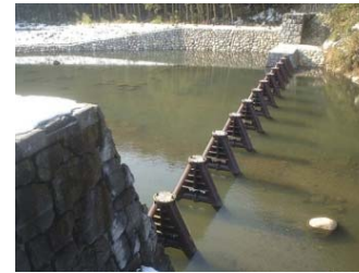
砂原砂防堰堤（東伯郡三朝町砂原） （流木捕捉工/H15.12）
