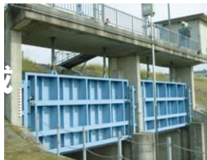
排水樋門（北田川）
