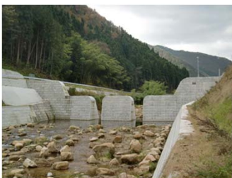
福本砂防堰堤（東伯郡三朝町上西谷） （コンクリート式／H24.3）
