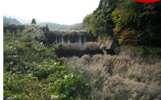
清水谷川第1号堰堤（倉吉市関金町堀） （張石コンクリート式／S12.7）
