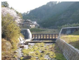
矢櫃砂防堰堤（倉吉市関金町山口） （鋼製スリット式／H14.1）
