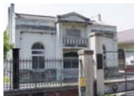
レトロモダンなポンプ室
