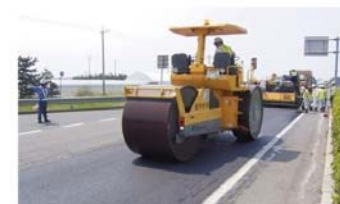
5 古く傷んだ道路をリフレッシュします
