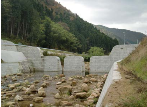
福本砂防堰堤（東伯郡三朝町上西谷） （コンクリート式／H24. 3）
