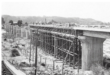
小田橋架替工事（昭和27年頃）
