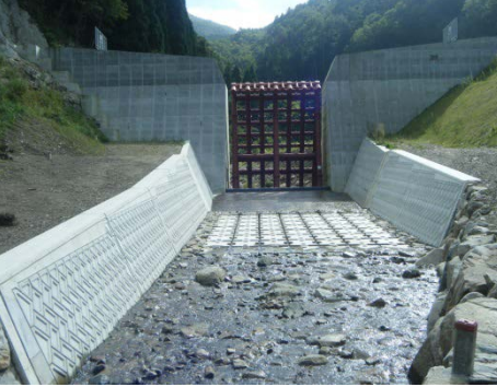
大谷砂防堰堤（東伯郡三朝町大谷） （鋼製スリット式／H27. 10）
