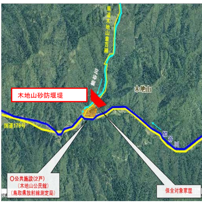
木地山砂防堰堤
