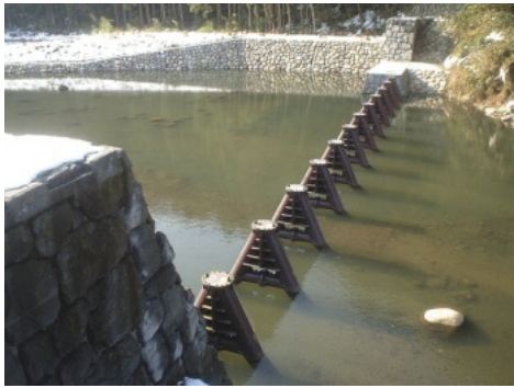
砂原砂防堰堤（東伯郡三朝町砂原） （流木捕捉工／H15. 12）
