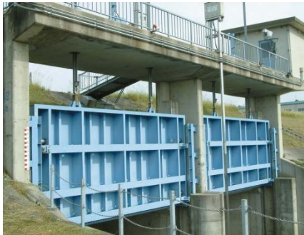
排水樋門（北田川）
