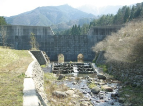
金谷砂防堰堤（倉吉市関金町金谷） （大口径暗渠式／H10. 11）
