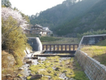
矢堰砂防堰堤（倉吉市関金町山口） （鋼製スリット式／H14. 1）
