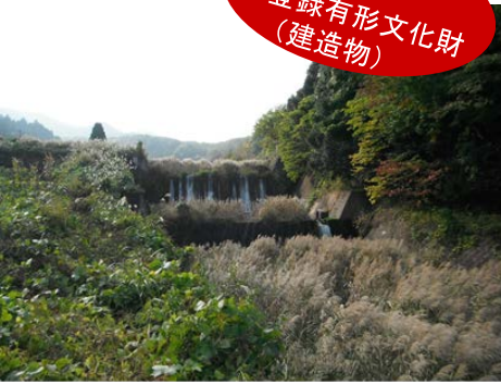
清水谷川第1号堰堤（倉吉市関金町堀） （張石コンクリート式／S12. 7）
