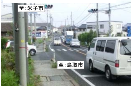
【八橋小学校入口交差点】
