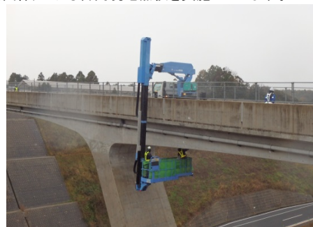
橋梁点検実施状況
