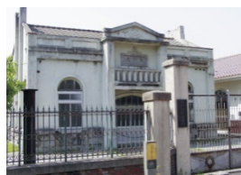
レトロモダンなポンプ室 ポンプ室は倉吉で最初の上水道施設として、昭和7年から平成2年3月まで水を汲み続けていた。
