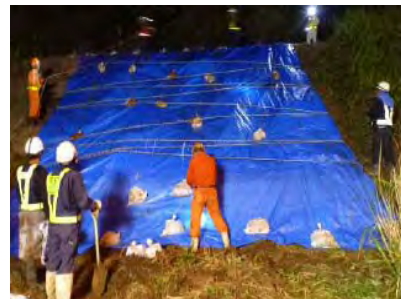
▲異常時（大雨等）の応急作業
