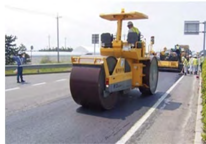
▲路面（アスファルト舗装）の補修
