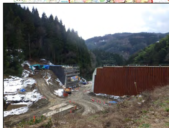
▲施工中の吉田砂防堰堤 (2018(H30)年12月)
