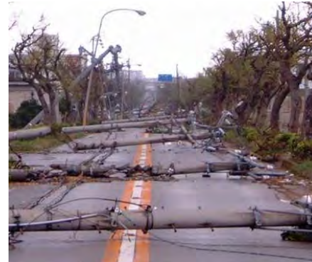
<電柱の倒壊による道路閉塞の事例>
