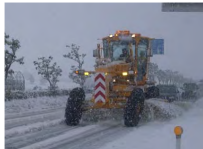
▲除雪グレーダーによる除雪作業
