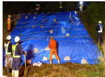
▲異常時（大雨等）の応急作業
