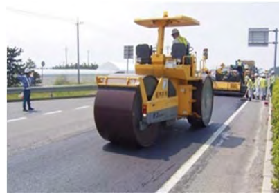
▲路面（アスファルト舗装）の補修
