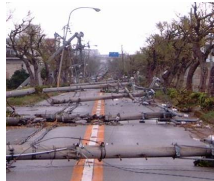
<電柱の倒壊による道路閉塞の事例>
