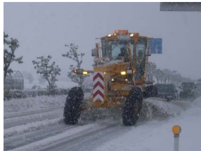
▲除雪グレーダーによる除雪作業
