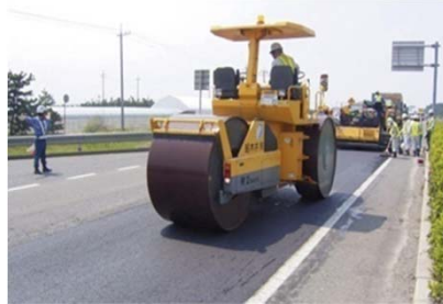
▲路面（アスファルト舗装）の補修
