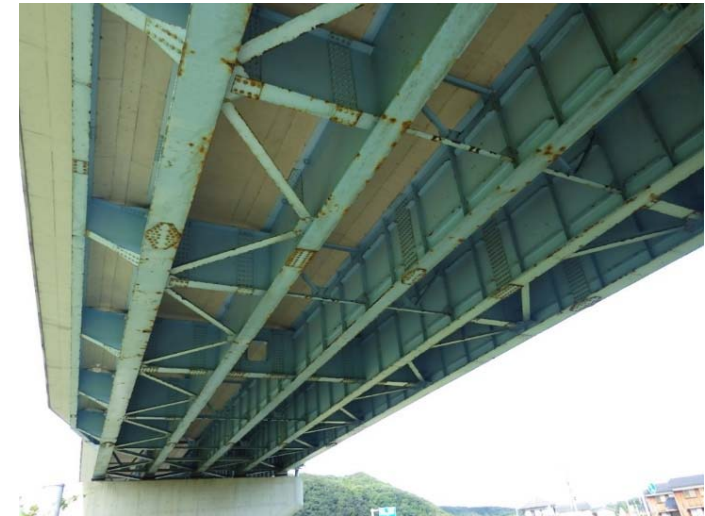
▲ 橋梁補修工事予定（青谷高架橋）
