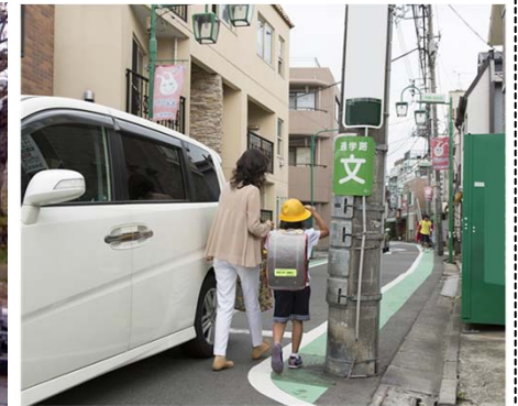
<歩行の支障となる電柱の事例>
