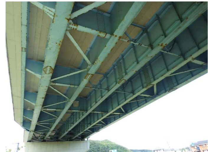
▲ 橋梁補修工事予定（青谷高架橋）
