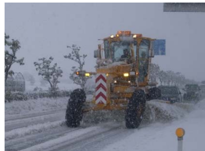
▲除雪グレーダーによる除雪作業
