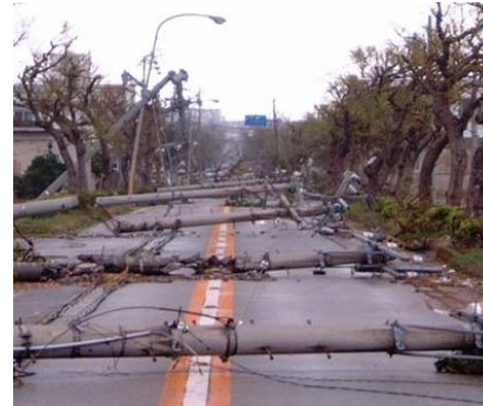
<電柱の倒壊による道路閉塞の事例>
