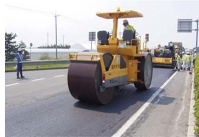
▲路面（アスファルト舗装）の補修
