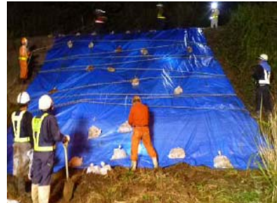
▲異常時（大雨等）の応急作業
