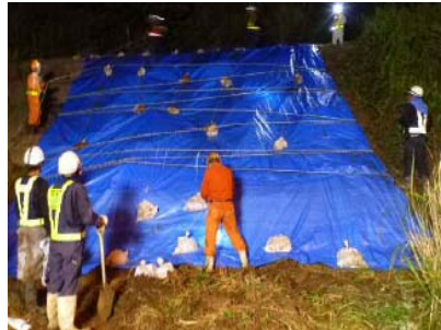
▲異常時（大雨等）の応急作業
