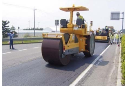
▲路面（アスファルト舗装）の補修
