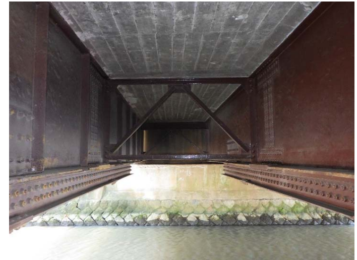
▲ 橋梁補修工事予定（淀江新大橋）
