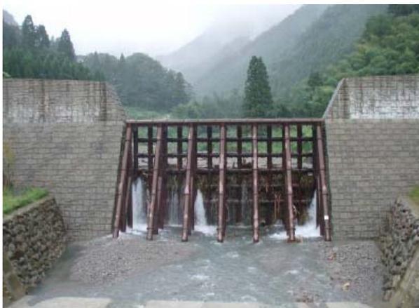
▲小泉2号砂防堰堤の土砂・流木補足状況
