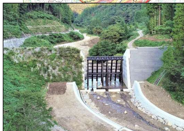
▲吉田砂防堰堤 (2019(R1)年9月完成)
