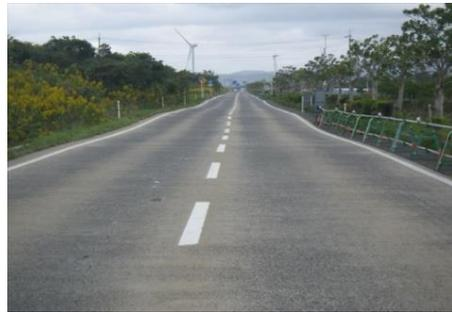
▲国道9号：地震による路面のうねり
