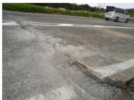
▲国道9号：地震による舗装の損傷
