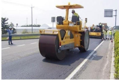
▲ 路面（アスファルト舗装）の補修
