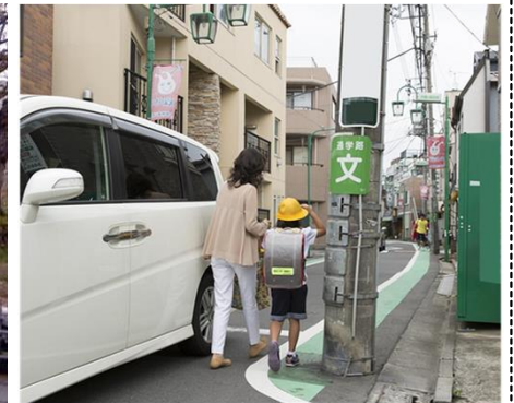
<歩行の支障となる電柱の事例>
