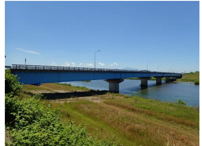
▲ 橋梁補修工事予定（新天神橋）
