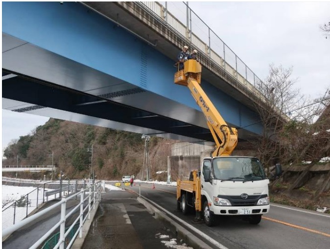
▲ 橋梁点検実施状況
