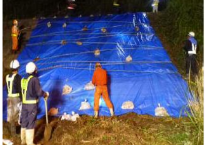
▲ 異常時（大雨等）の応急作業
