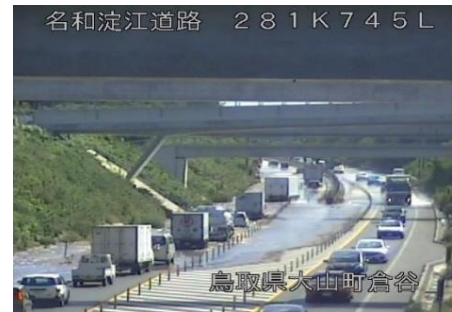
▲山陰道：豪雨による浸水
