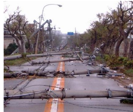
<電柱の倒壊による道路閉塞の事例>
