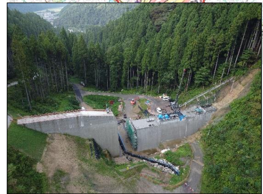
▲穴鴨4号砂防堰堤 (施工中)
