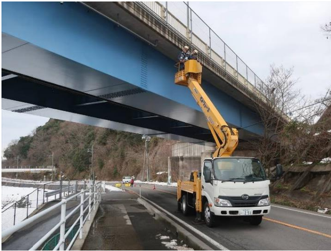
▲ 橋梁点検実施状況
