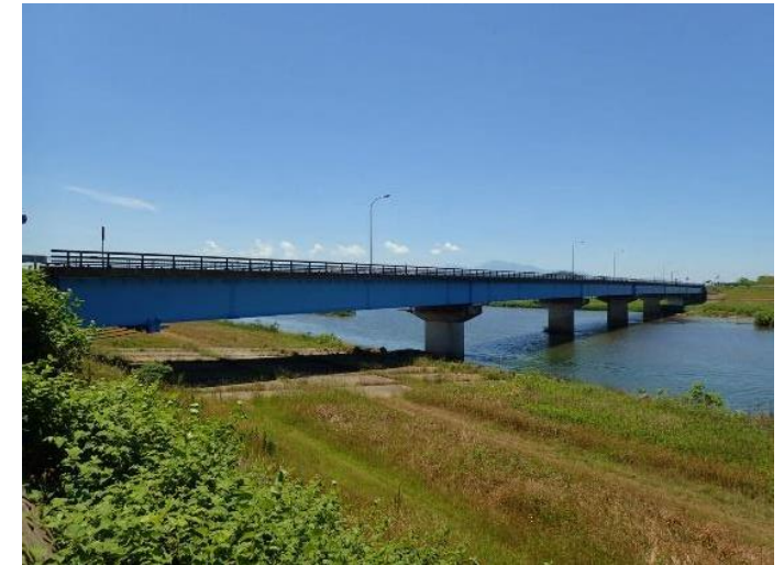
▲ 橋梁補修工事予定（新天神橋）
