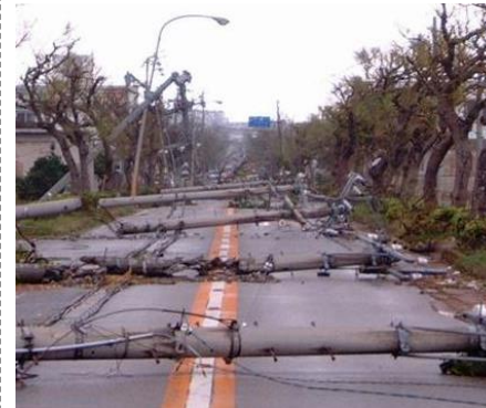
<電柱の倒壊による道路閉塞の事例>
