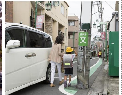
<歩行の支障となる電柱の事例>
