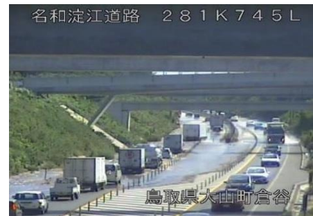
▲山陰道：豪雨による浸水
