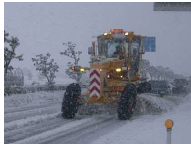
▲除雪グレーダーによる除雪作業
