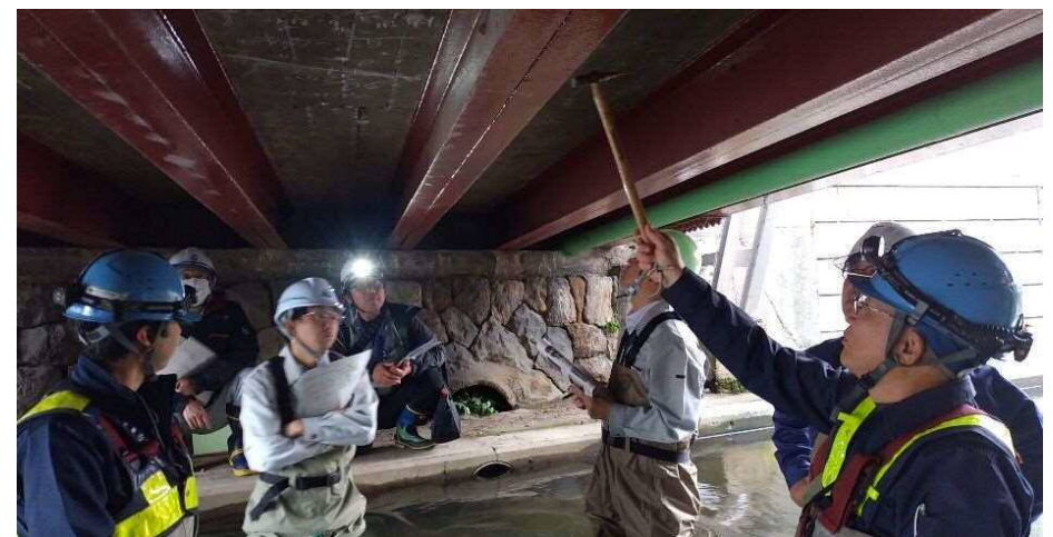
▲ 橋梁点検講習会（自治体支援）実施状況▲
