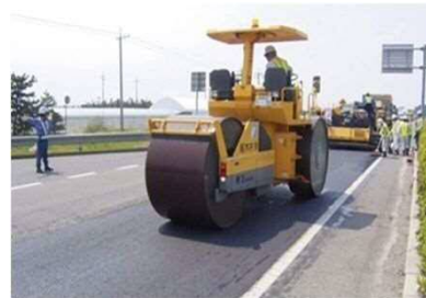
▲路面（アスファルト舗装）の補修
