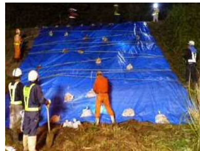
▲異常時（大雨等）の応急作業
