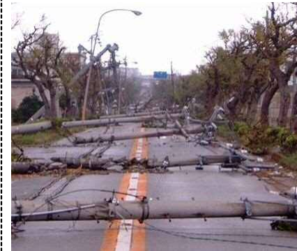
&lt;電柱の倒壊による道路閉塞の事例&gt;
