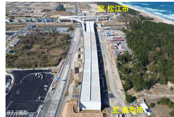
▲写真① 北条JCT (仮称) より松江市方面を望む
