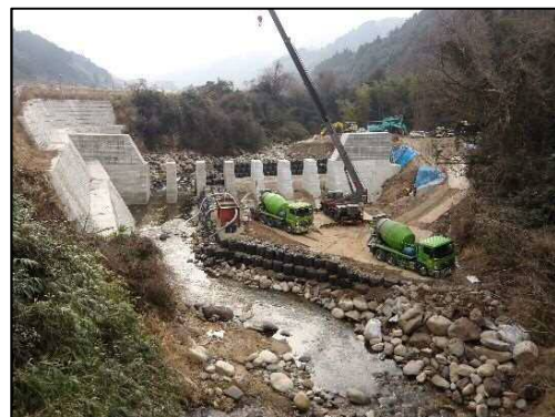
▲西尾砂防堰堤(施工中 R7.1)
