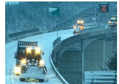
▲協力業者によるスタック車両牽引
