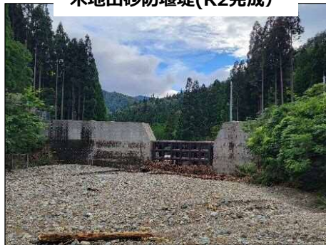
木地山砂防堰堤(R2完成)
