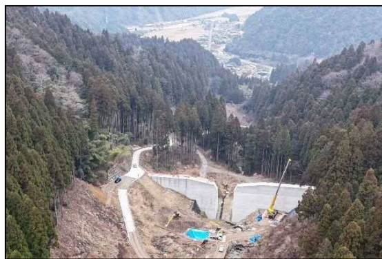
▲穴鴨4号砂防堰堤(施工中 R7.1)
