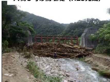
穴鴨3号砂防堰堤(H25完成)
