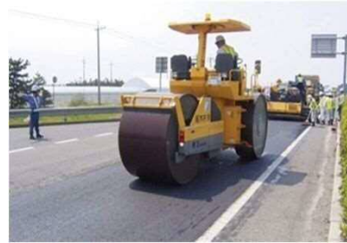
▲路面（アスファルト舗装）の補修
