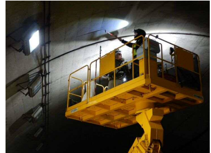
▲ トンネル点検実施状況
