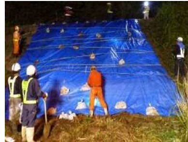
▲異常時（大雨等）の応急作業
