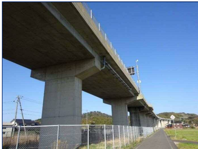
▲ 橋梁補修工事予定（羽合高架橋）
