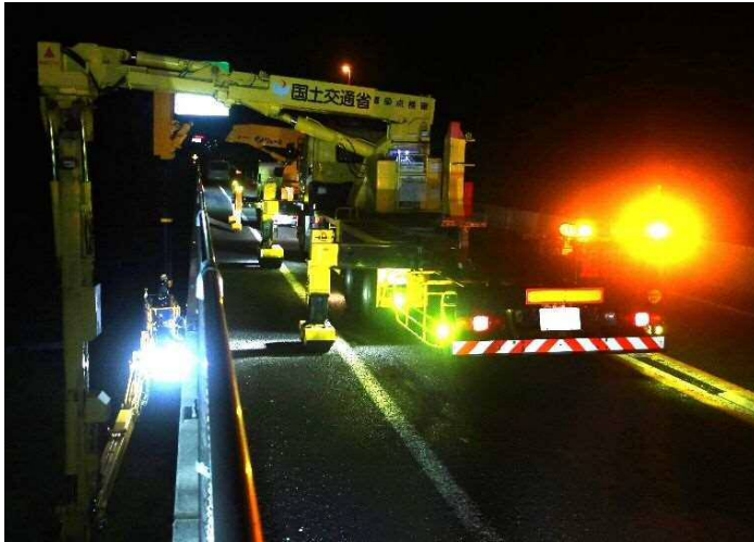
▲ 橋梁点検実施状況
