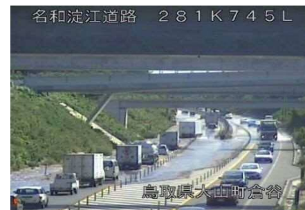
▲山陰道：豪雨による浸水
