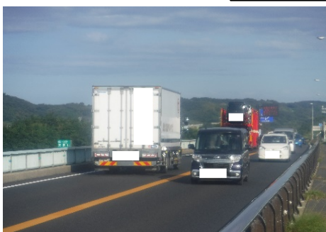
写真1 国道9号新天神橋
