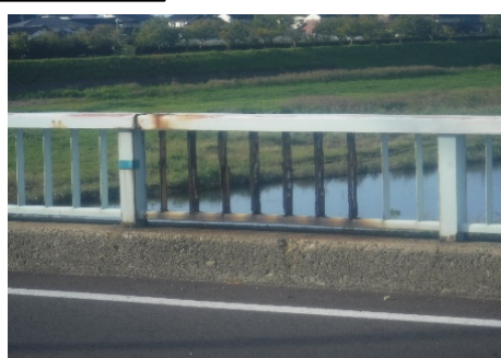
写真2 防護柵腐食状況
