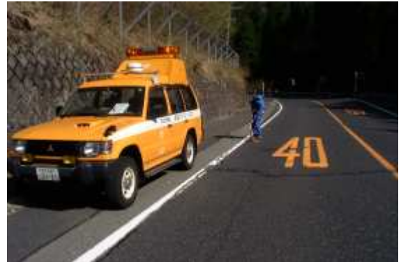
落下物(破片)除去作業中
