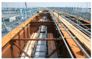
※海浜海岸耐候性鋼材とは、鋼 材に発生するサビ層が塗装に かわって腐食を防ぎ、塗装作 業とその塗り替え作業の省略 により維持管理費が軽減する 鋼材です。
