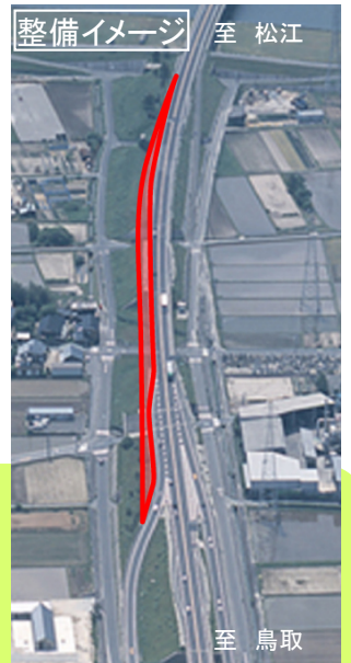
加速車線延長箇所
