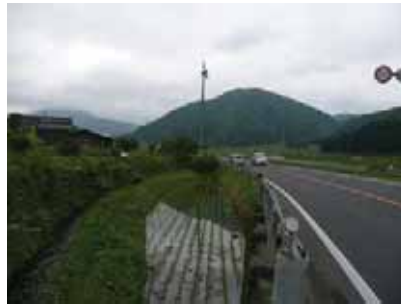
両側に歩道がない現況
