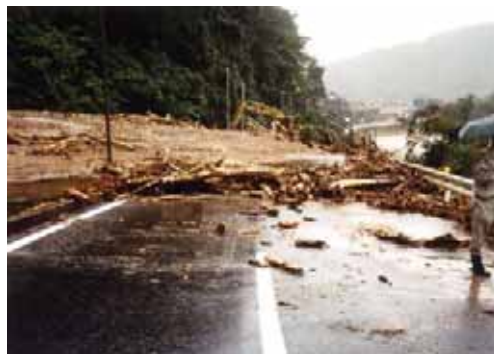
▲H10台風10号による被災状況
