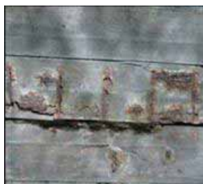
主桁の剥離・鉄筋露出
