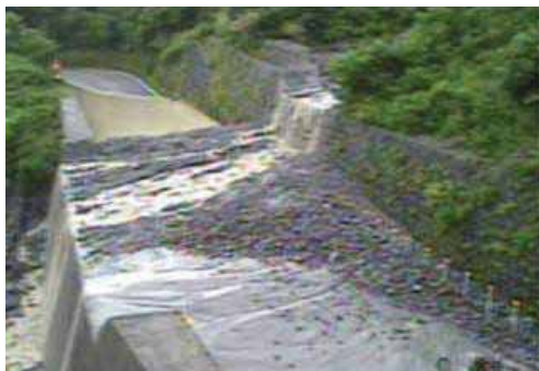
▲大山環状道路への土砂流出状況
