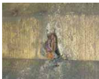
下部工の剥離・鉄筋露出
