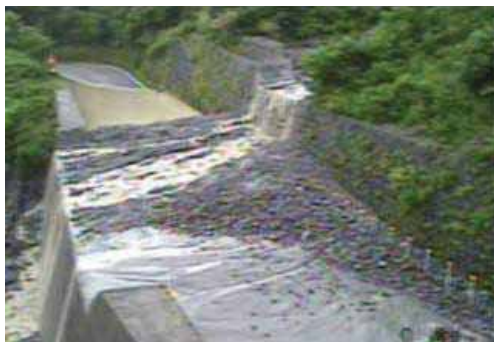
▲大山環状道路への土砂流出状況
