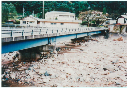
河床を埋めた土砂 (大渡橋)
