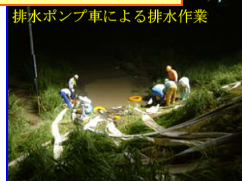
排水ポンプ車による内水排除
