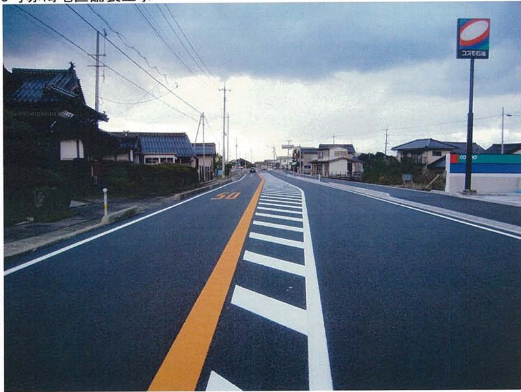
国道9号赤碕地区舗装工事
