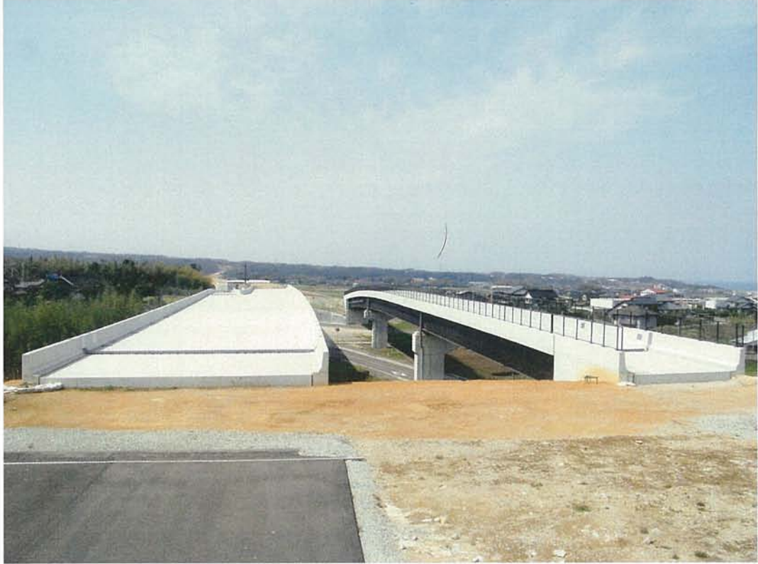
東伯中山道路赤碕第2高架橋床版工事 (起点側)
