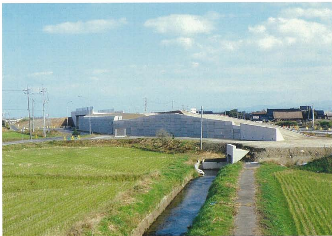
東伯中山道路二軒屋改良工事
