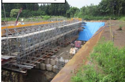
現地状況写真③
