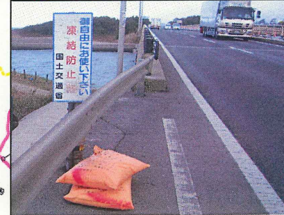
凍結防止材袋設置状況
