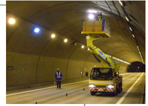
トンネル点検車にて点検作業(例)
