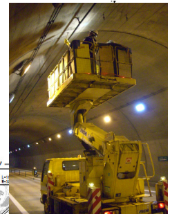
トンネル点検車にて点検作業 (H24.11 状況)
