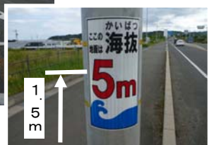
設置方法・デザイン等検討のため設置した事例 【設置箇所】国道9号長瀬新川入口 交差点付近
