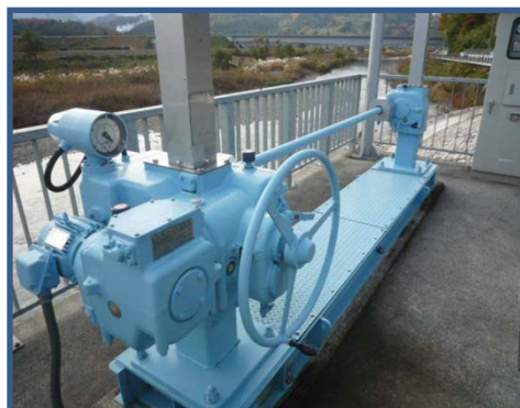
電動式の開閉装置
