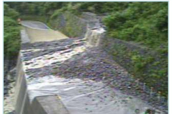
大山環状道路への土砂流出状況
