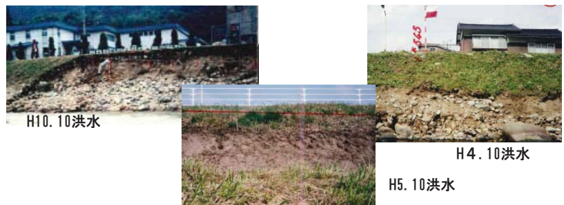
管内の過去災害においても、堤防法面が侵食され事例頻発
