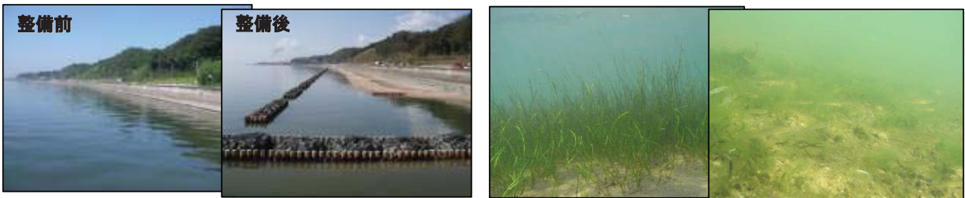
宍道湖や中海の殆どが人工湖岸です。 (事例:宍道湖のコンクリート護岸)
