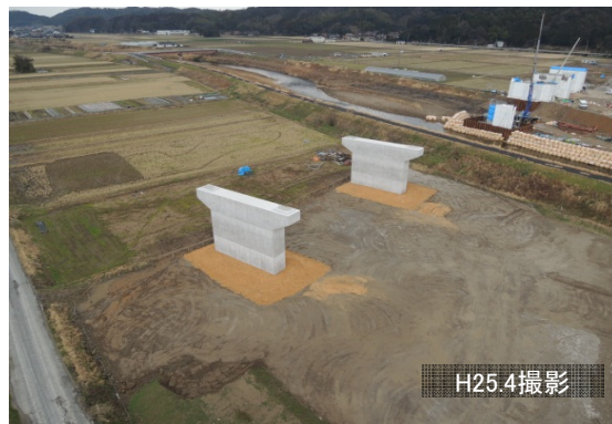
【写真④】鳥取市気高町下坂本地区(河内川付近)
