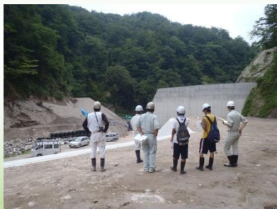
工事現場見学（倉吉市関金町）
