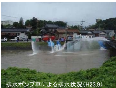
排水ポンプ車による排水状況 (H23.9)
