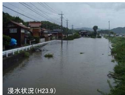
浸水状況 (H23.9)
