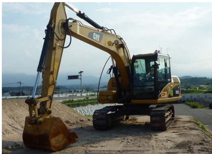
使用するバックホウ(全景)
