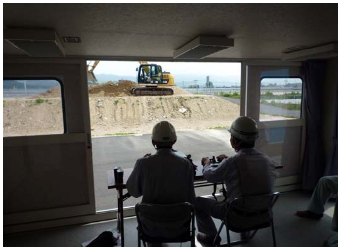
オペレータによる遠隔操作状況
