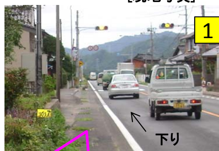
下り側歩道なし 上り側歩道W=1.0m程度
