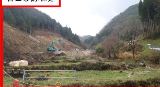
吉田砂防堰堤において、土砂災害の軽減及び三徳川への土砂流出の抑制を目的として、付替道路工事と砂防堰堤本体工を促進します。
