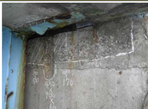
損傷状況(部材の断面欠損)
