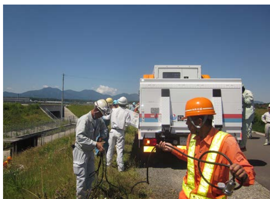
排水ポンプ車 排水訓練状況
