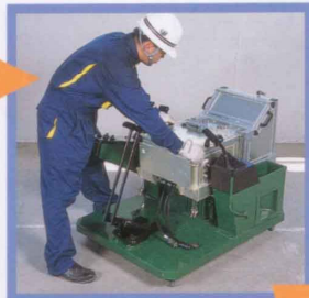
コントロールユニット(ロボットの頭脳:コンピュータ)の取り付け
