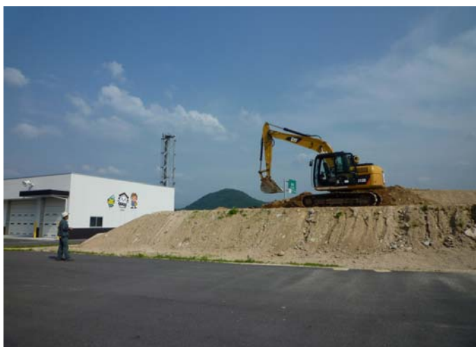
オペレータによる近距離での操作状況
