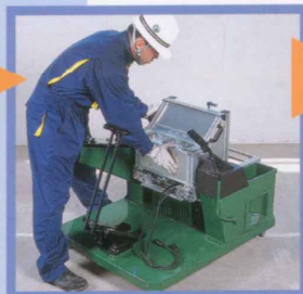
サーボユニット(圧縮空気で各部分を動かす)の取り付け
