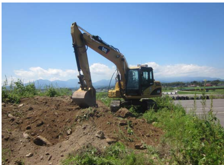
使用するバックホウ(全景)
