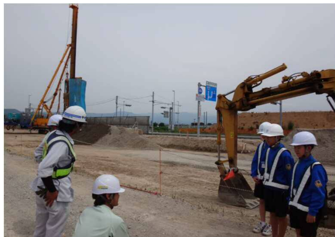
道路工事現場見学
