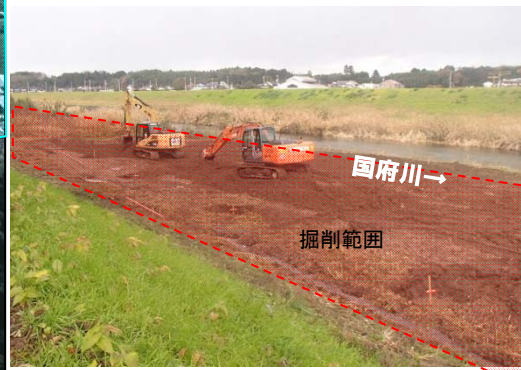
<掘削状況写真>
