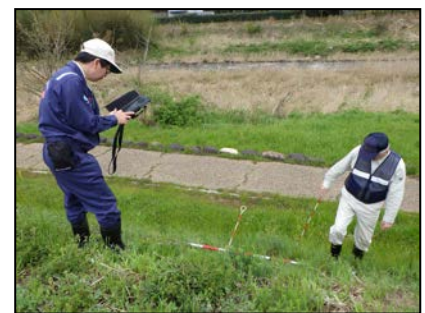
堤防点検の様子
