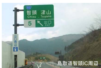
▲設置事例(鳥取自動車道)
