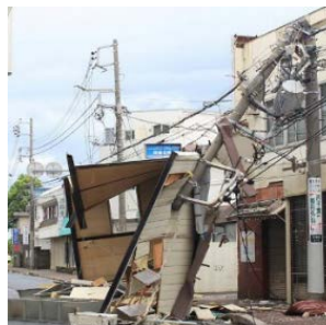
<飛来物による電柱倒壊の事例>
