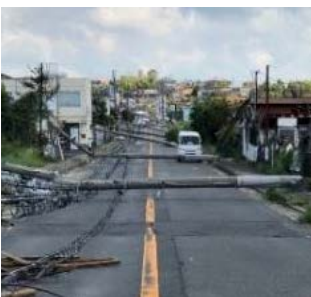
<電柱の倒壊による道路閉塞の事例>
