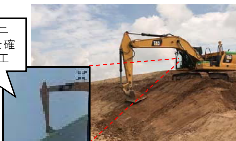
バックホウによる法面整形
