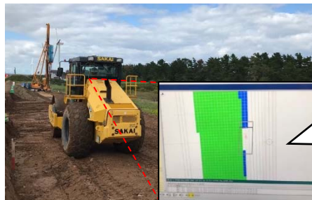
ローラーによる盛土転圧
