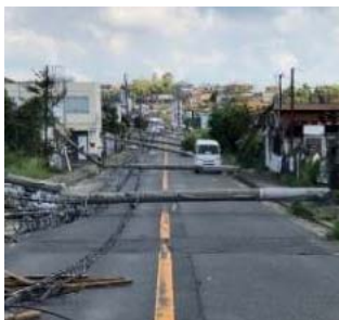
<電柱の倒壊による道路閉塞の事例>
