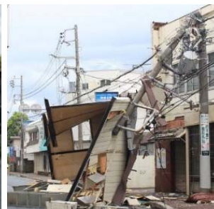
<飛来物による電柱倒壊の事例>
